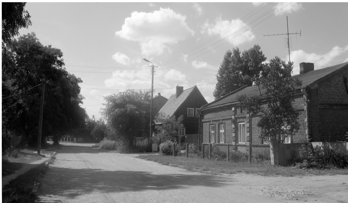
Fot. 1. Ulica Nagórna w Kole. Photo 1. Nagórna Street in Koło.
