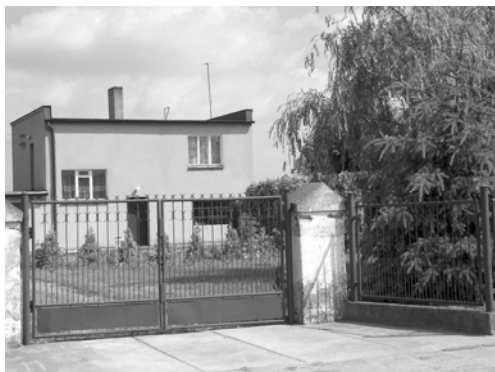
Fot. 1. Po wyburzeniu starych domostw ukazują się domy-kostki wybudowane w głębi podwórza. Photo 1. After old houses are demolished cube-shaped houses built in the back yards appear.
